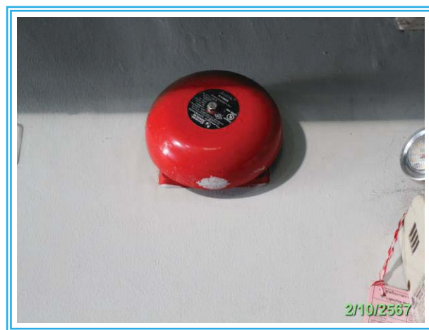
รูปที่ 2.5-11 อุปกรณ์ส่งเสียงสัญญาณแจ้งเหตุอัคคีภัย
