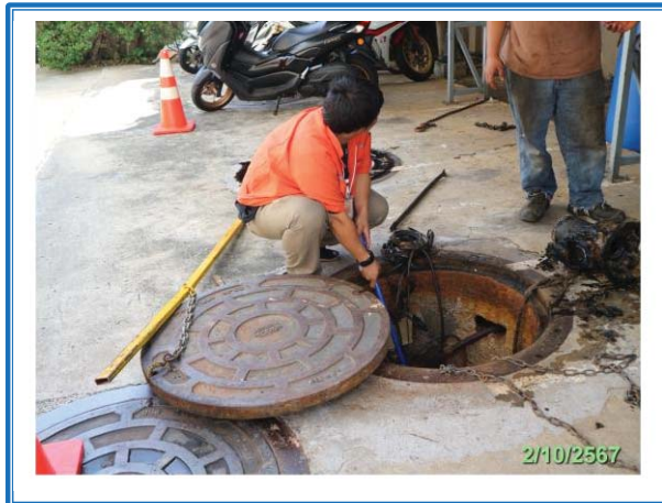
รูปที่ 3-32 ตักไขมันออกจากบ่อดักไขมัน
